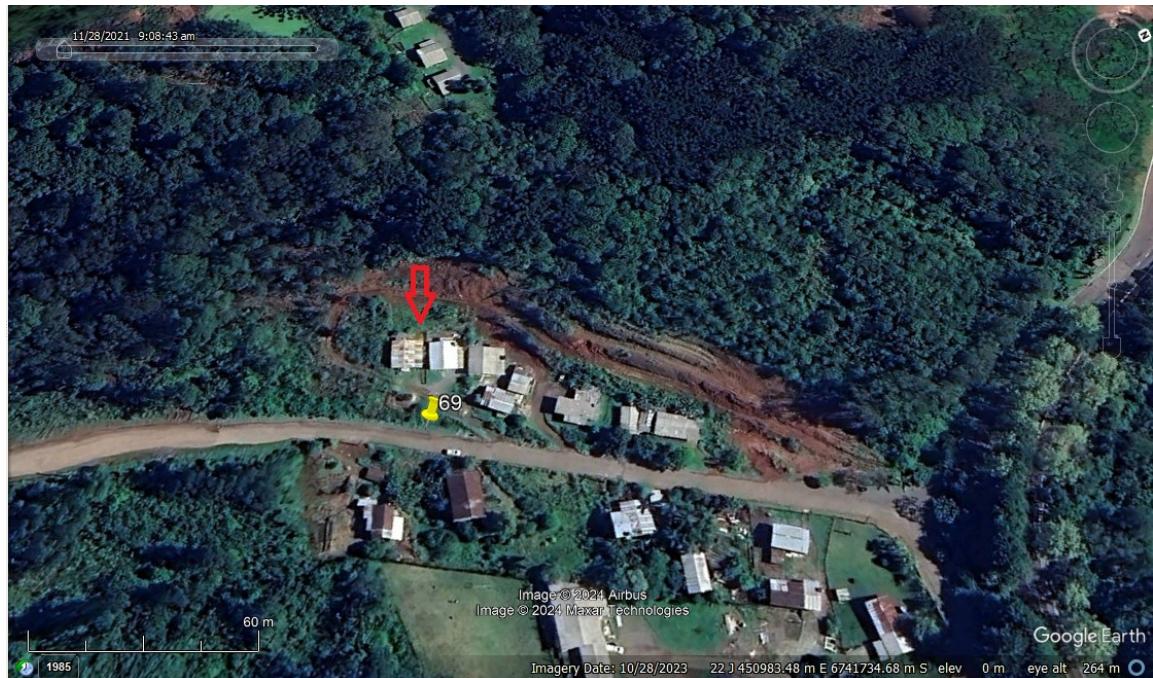
Figura 1: Imagem de satélite do local atingido pelo deslizamento demonstrando que havia desmatamento da encosta mostrada na seta em vermelho à casa que foi atingida.
