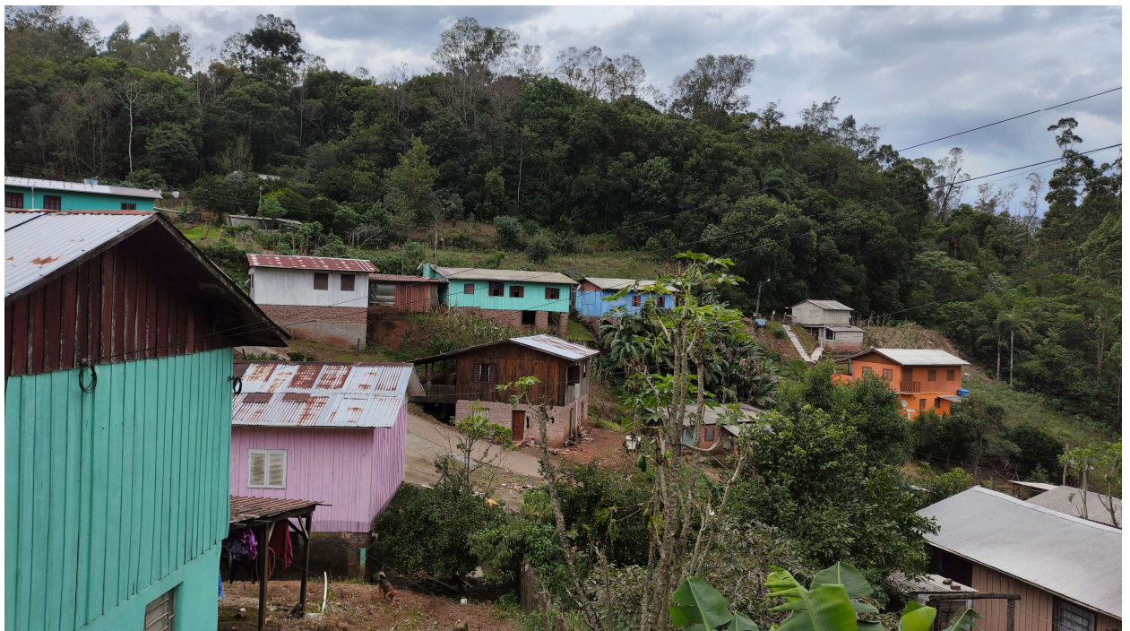
Fotos de residências evacuadas em locais de invasão e área de risco.
